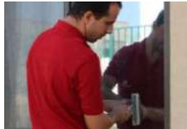
**Schritt 11:** Befeuchten Sie die Folie nochmals und pressen Sie den Rakel fest von innen nach außen, bis alle Lufteinschlüsse und Wasserrückstände von den Rändern entfernt wurden.
