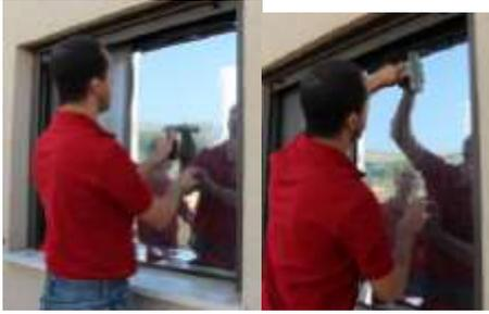
**Schritt 8:** Wischen Sie einen robusten 6-Zoll Sicherheitsfolien-Rakel mit festen Bewegungen von der Mitte nach unten und außen, um Wasser- und Lufteinschlüsse zwischen Folie und Glas herauszuschieben.
