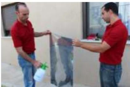
**Schritt 2:** Besprühen Sie die Folie auf beiden Seiten, damit sie sich nicht statisch auflädt (zieht weniger Schmutz bei der Verklebung an) und um sie zu glätten.
