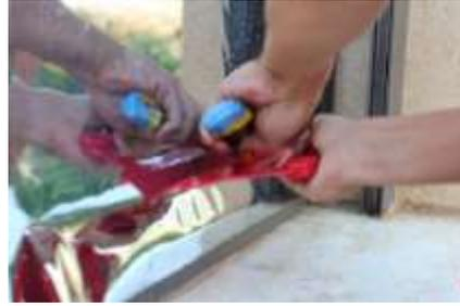
**Schritt 9:** Schneiden Sie die Kanten der Folie am Fensterrahmen mit dem Teppichmesser und dem Schneidzeug zu.
