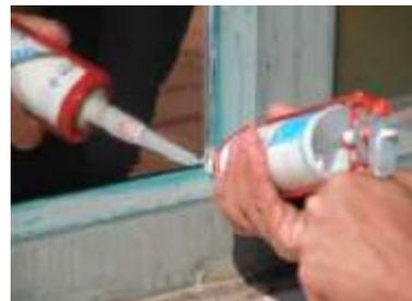
**Schritt 13:** Lassen Sie die Folie 24 Stunden trocknen und versiegeln Sie danach alle vier Seiten innerhalb von 72 Stunden.
