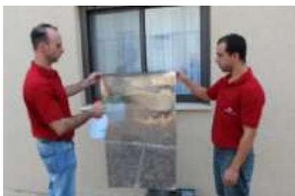
**Schritt 6:** Entfernen Sie das Trägermaterial von der Folie und besprühen Sie die Klebstoffschicht mit reichlich Benetzungslösung.
