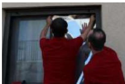
**Schritt 7:** Legen Sie die Folie mit der nassen Klebstoffseite auf das Fenster.
