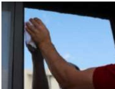
**Schritt 12:** Wischen Sie die Kanten der Folie und des Fensters mit einer in Papiertuch umwickelten Karte trocken.
